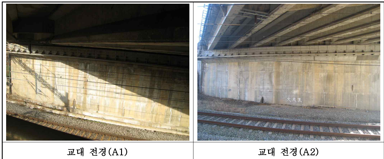
【사진 1.3.8】 교대 전경
