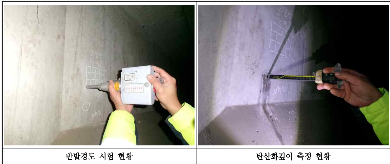
【사진 1.4.1】 콘크리트 내구성조사 현황
