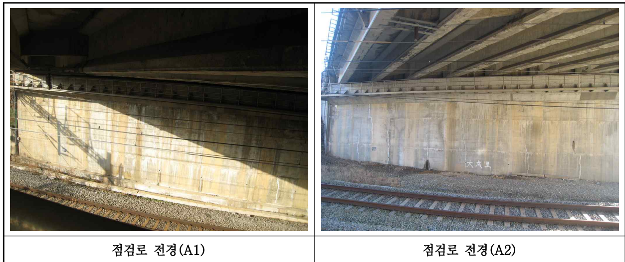
【사진 1.3.23】 교량 점검시설 전경
