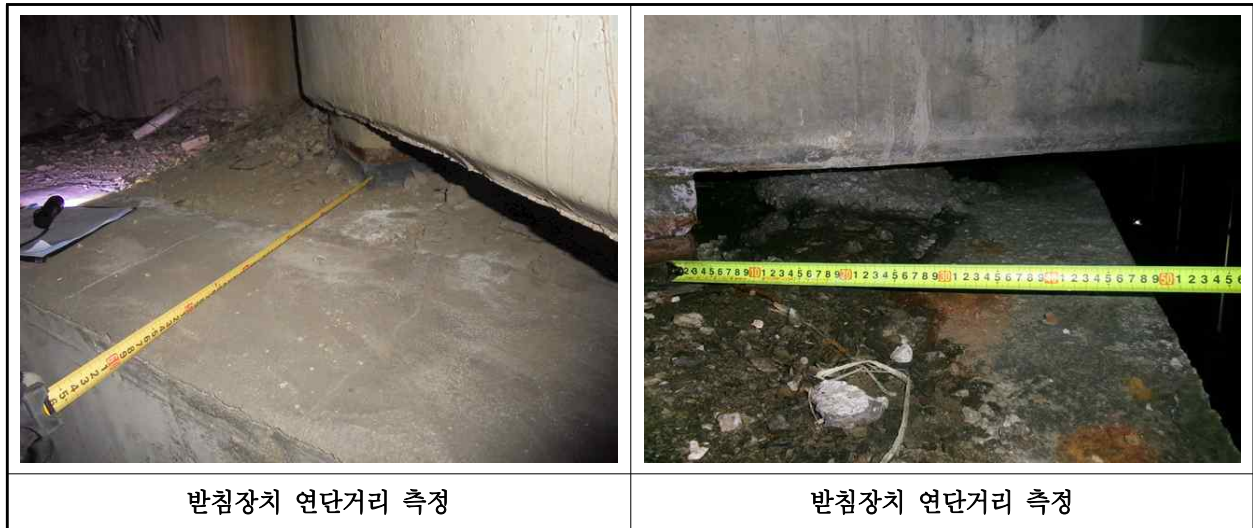
【사진 1.3.12】 교량받침장치 연단거리측정
