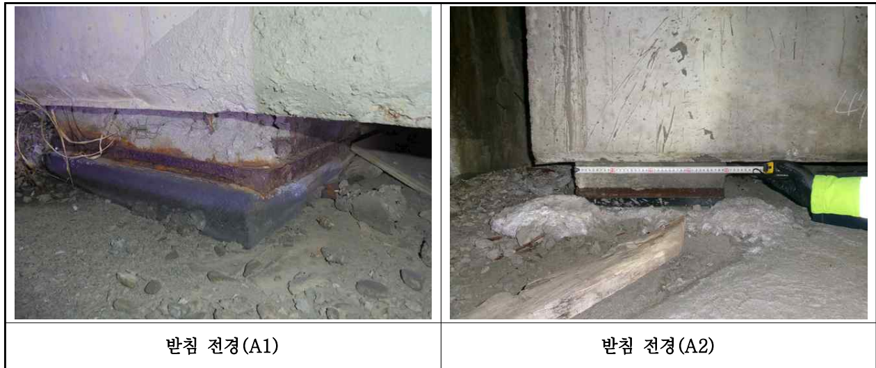
【사진 1.3.10】 교량받침 전경
