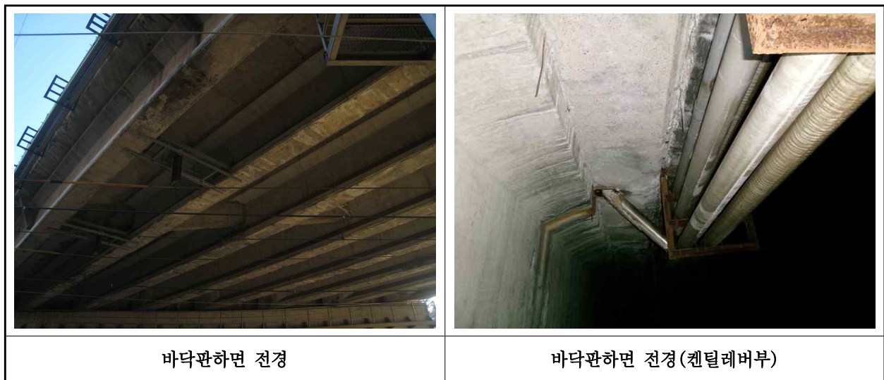
【사진 1.3.2】 바닥판하면 전경
