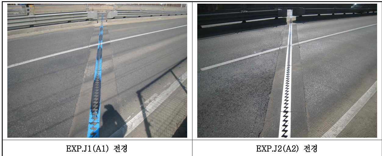
【사진 1.3.14】 신축이음장치 전경
