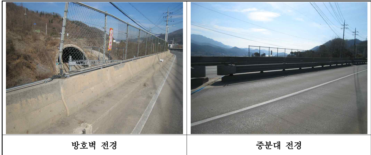
【사진 1.3.21】 방호벽 및 중앙분리대 전경
